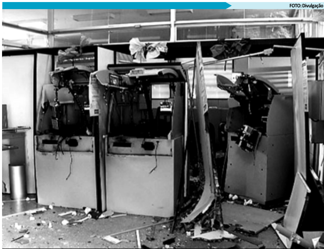
Em 2011, dos 71 casos contabilizados, foram 37 explosões, 9 assaltos, 16 arrombamentos e 9 tentativas de assalto
